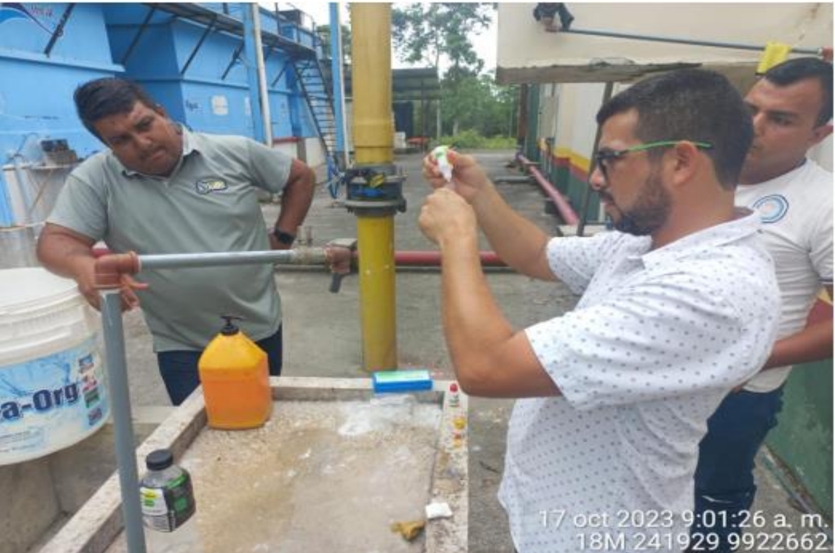
Prueba de reactivos para determinar la presencia del Cloro y PH en aguas tratadas.
