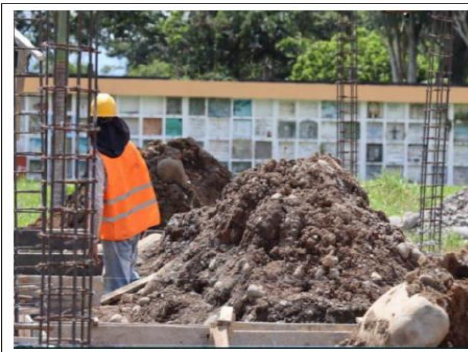
Imagen 9: Inicio de construcción del Bloque 192 nichos.
