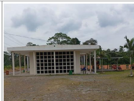
Imagen 2: Bloque de construcción finalizada al 100%.
