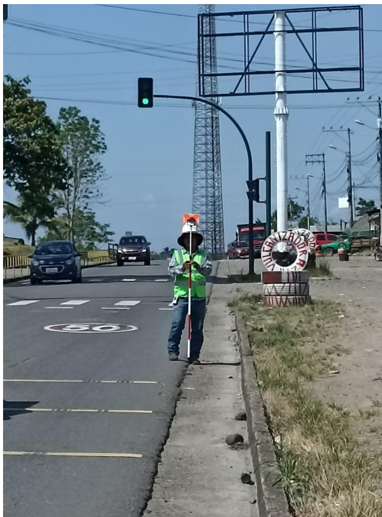
Toma de Puntos Topográficos de referencia (GPS) en Juan Montalvo.
