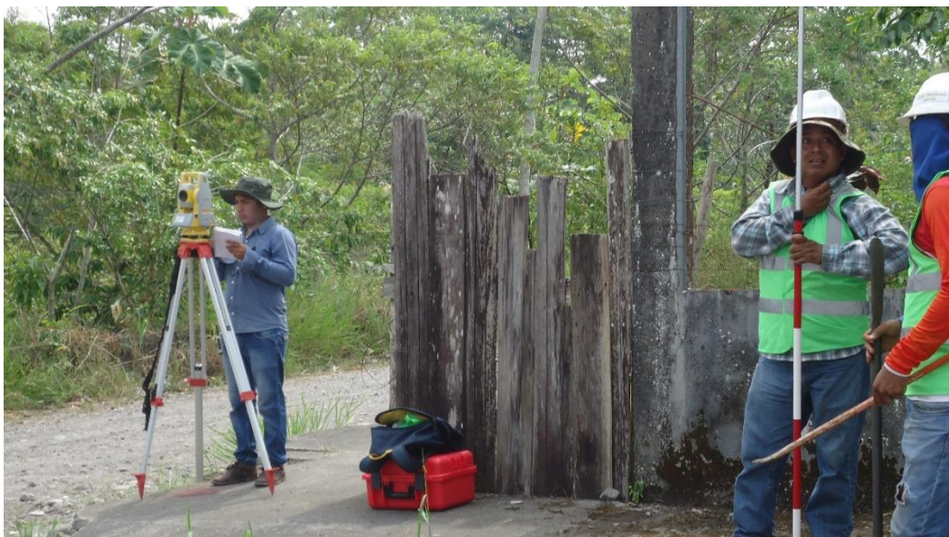
Toma de Puntos Topográficos de referencia (GPS) zona centro.
