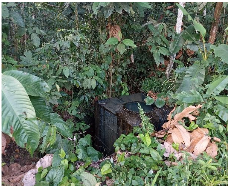
Planta Tratamiento Zona Norte
