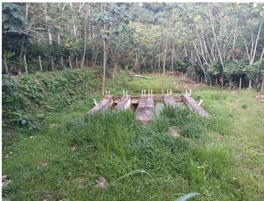
Planta Tratamiento Zona Centro Ciudad
