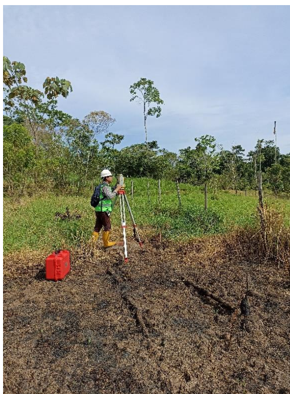
Toma de Puntos Topográficos de referencia (GPS) Vía Planta Tratamiento sector Juan Montalvo - Laguna de Oxidación.
