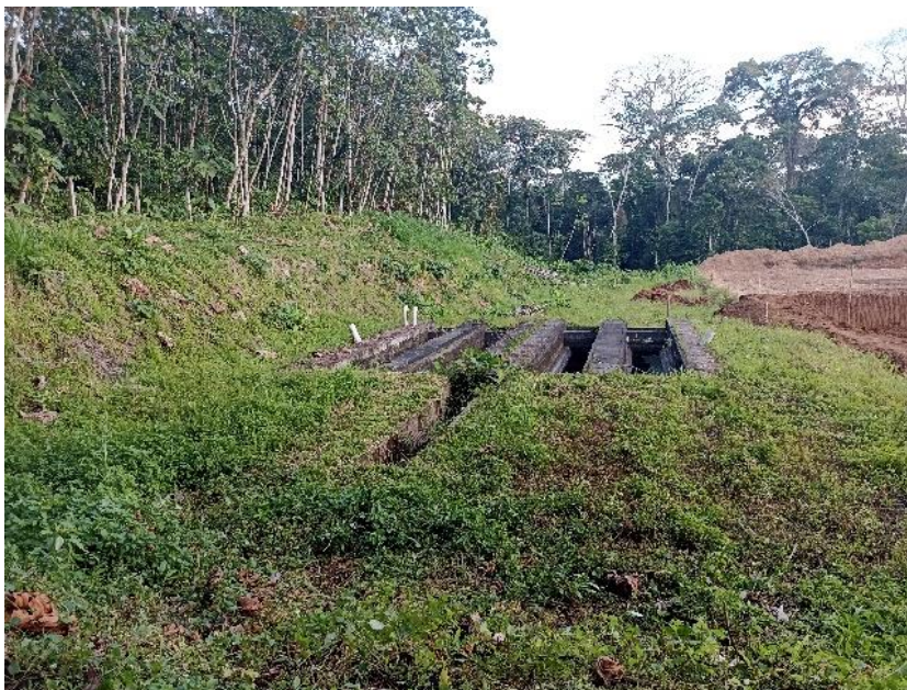
Planta Tratamiento Zona Norte
