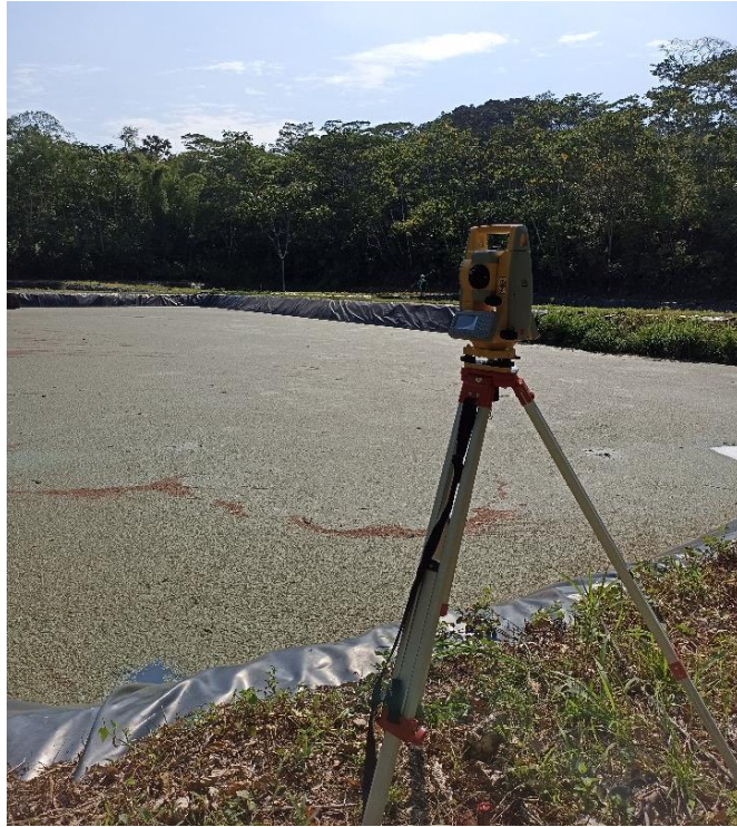
Toma de Puntos Topográficos de referencia (GPS) Planta Tratamiento sector Juan Montalvo Laguna de Oxidación.
