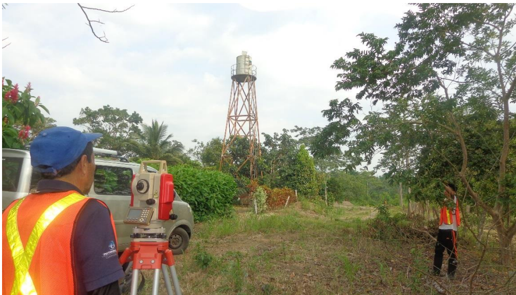
Estación total y personal en el levantamiento Topográfico
