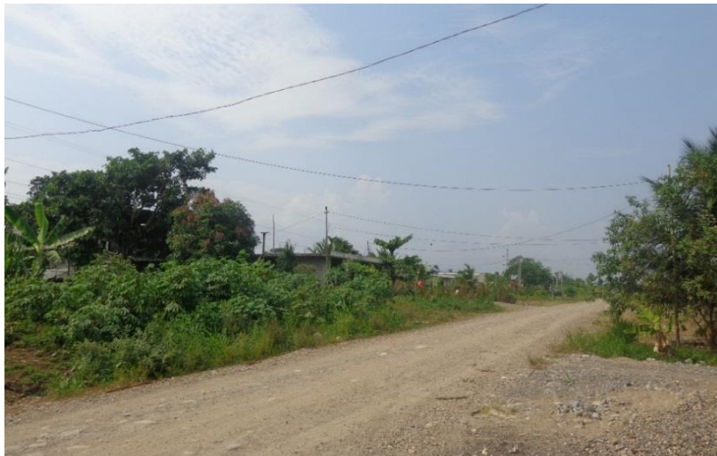
Vía lastrada dentro del área de paso y cobertura del proyecto
